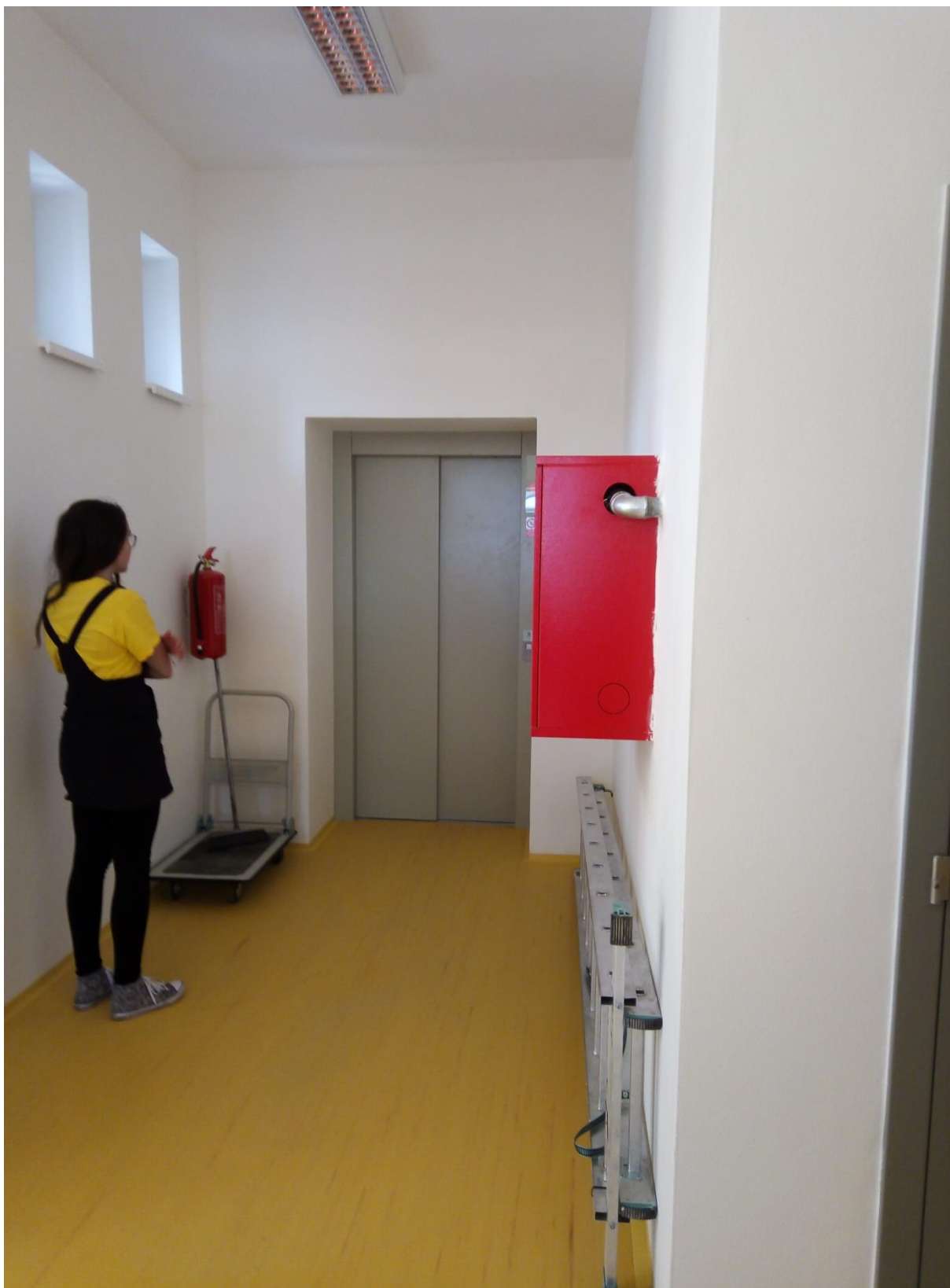
Obr. 14 Školní budova byla nově vybavena výtahem pro handicapované studenty
