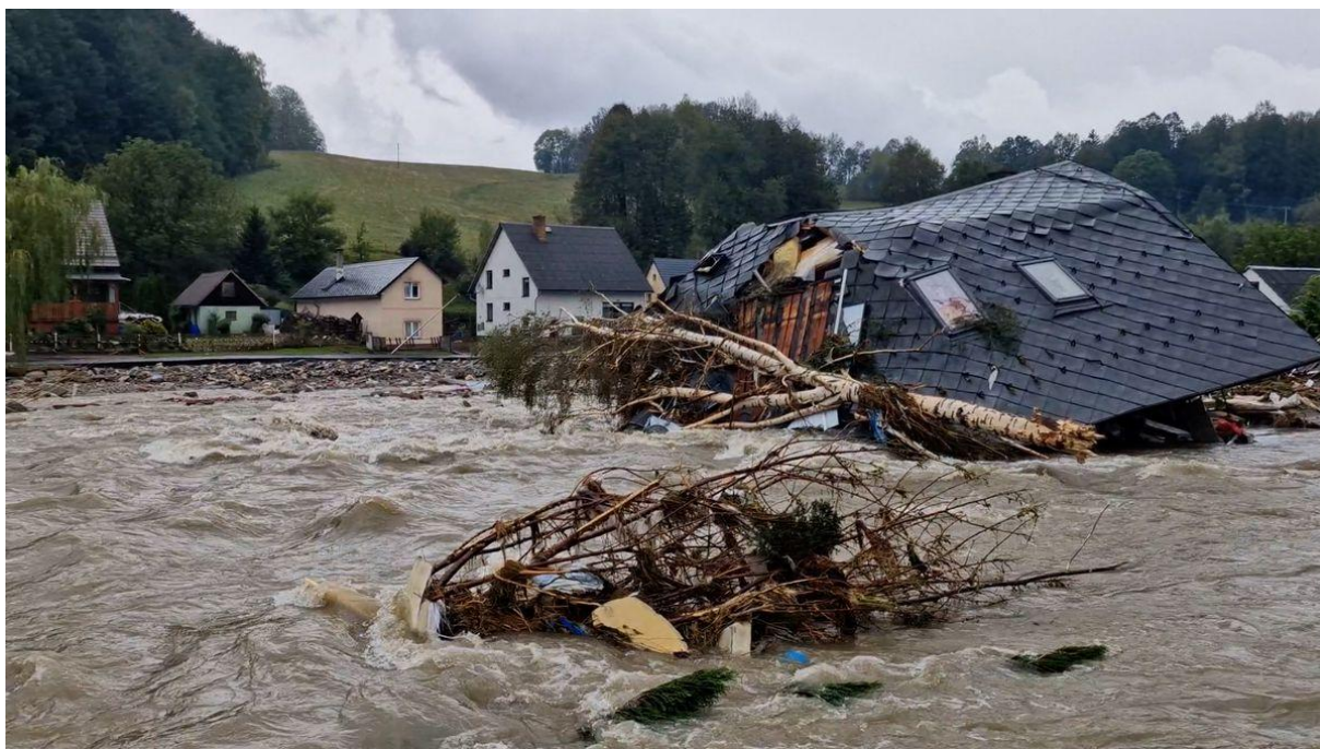
OBR. 3 Škody způsobené zářijovými povodněmi na severní Moravě - Novojičínku
