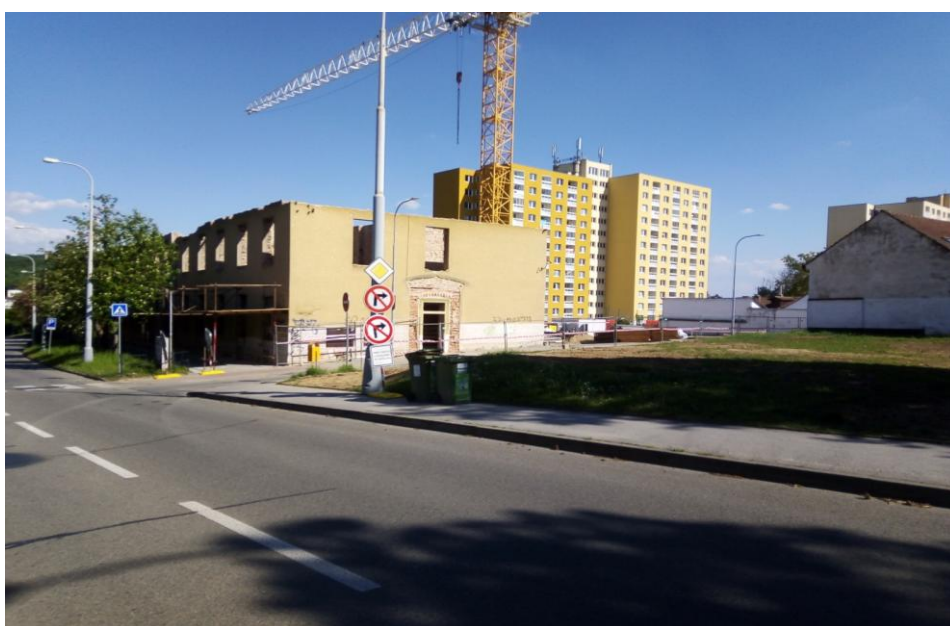
Obr. 10 Práce za školní budově pokračují (snímek z 17.6. 2020)
