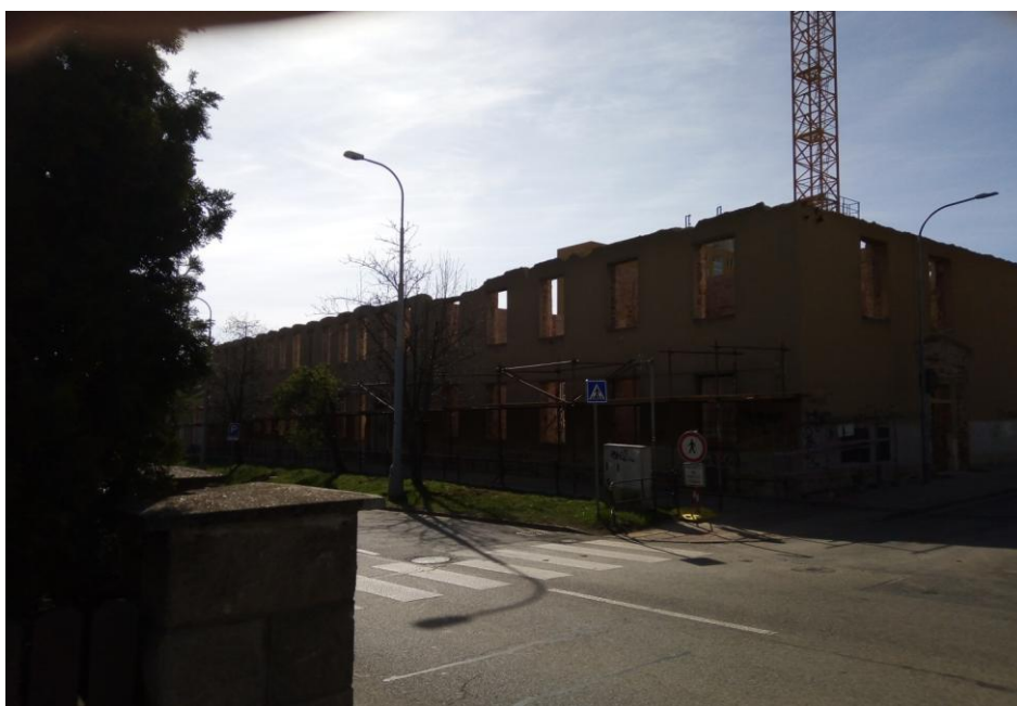
Obr. 8 Na snímku z 15.4. 2020 už budova školy na Hapalově nemá střechu, zbývají obvodové zdi.
