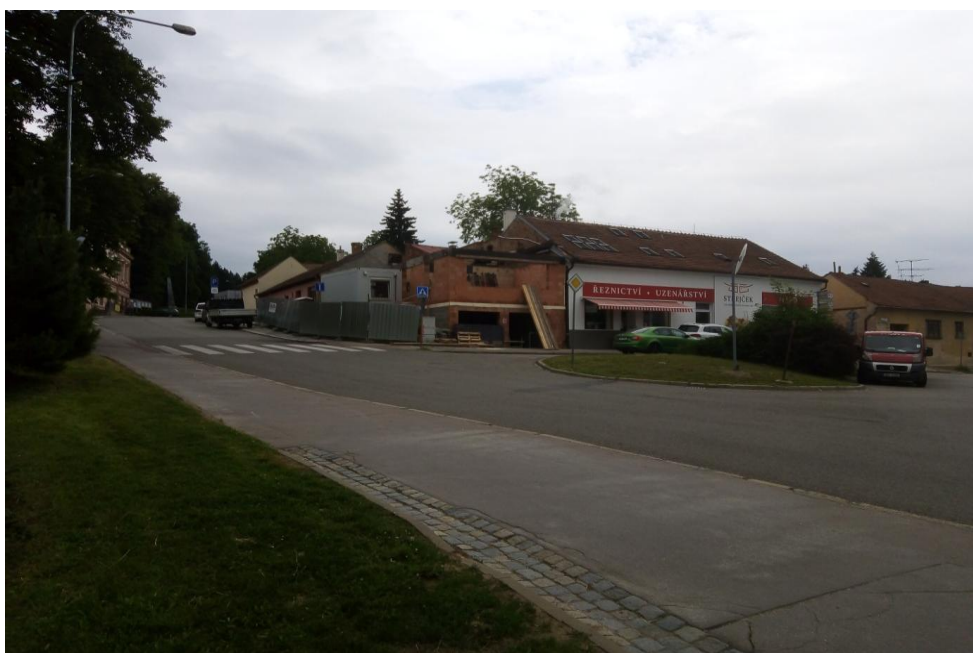
Obr. 11 Tak vypadala stavba v polovině června 2020 - obvodové stěny rostou.
