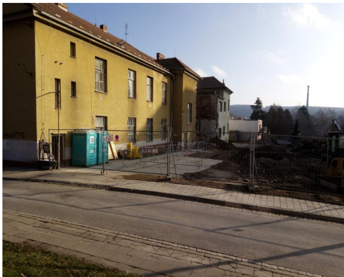
Obr.1 Rekonstrukce budovy bývalé školy na Hapalově. Nejprve vzaly za své přístavby ve dvoře.
