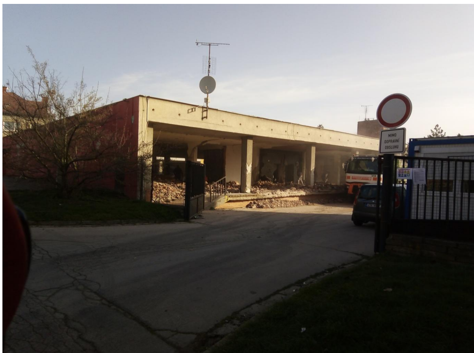
Obr. 7 Začátek rekonstrukce bývalého Nákupního střediska Měřickova, později restaurace U Maníka. Snímek z 27.3.2020
