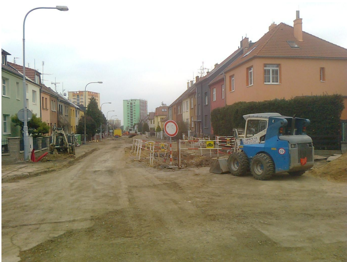
Obr. 3 Stav prací ul. Vránova podzim 2014 – pohled od Dlouhých honů
