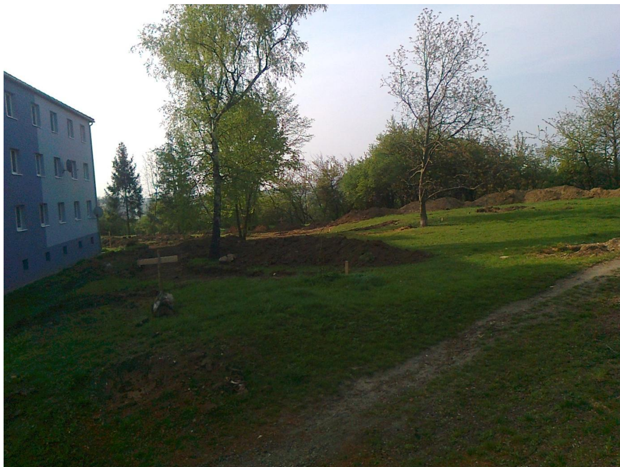
Obr. 1 Duben 2014 – začátek prací
