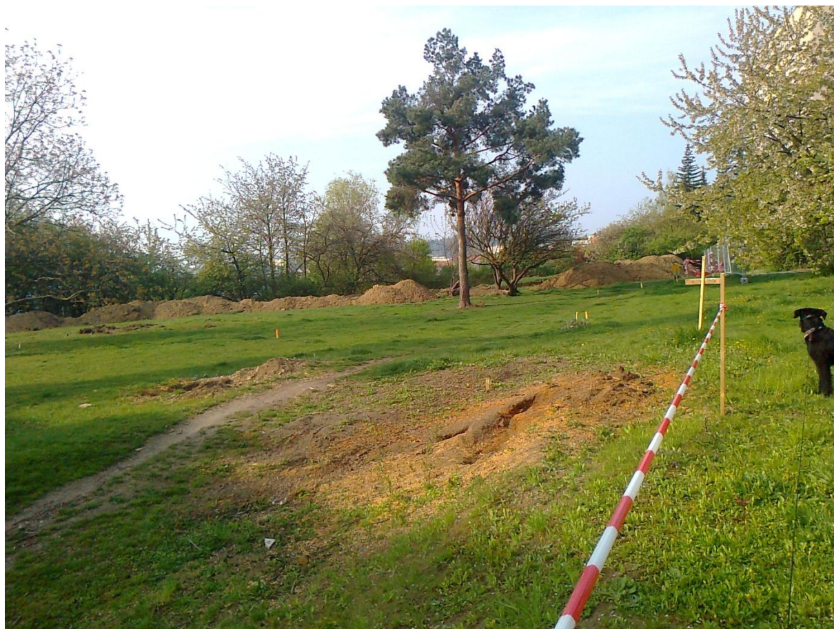
Obr. 2 Duben 2014 - začátek prací
