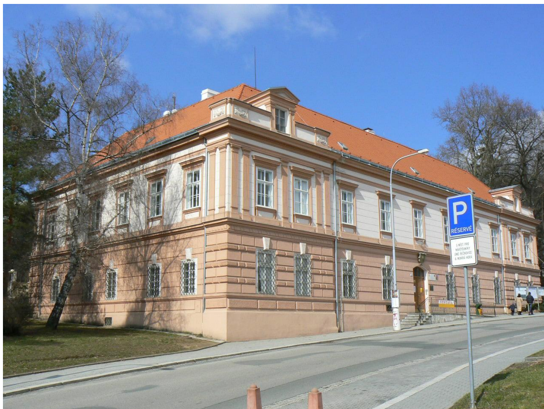
Obr. 6 Budova řečkovické radnice po celkové rekonstrukci střechy
