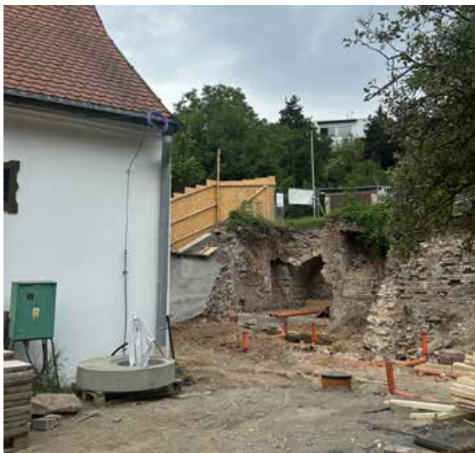
Probíhající stavební práce v areálu.
